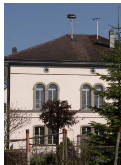
Altes Gemeindehaus, Westansicht
