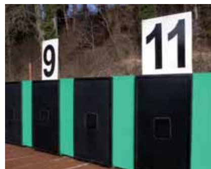
Schiessanlage Riet, künstliche Kugelfänge
